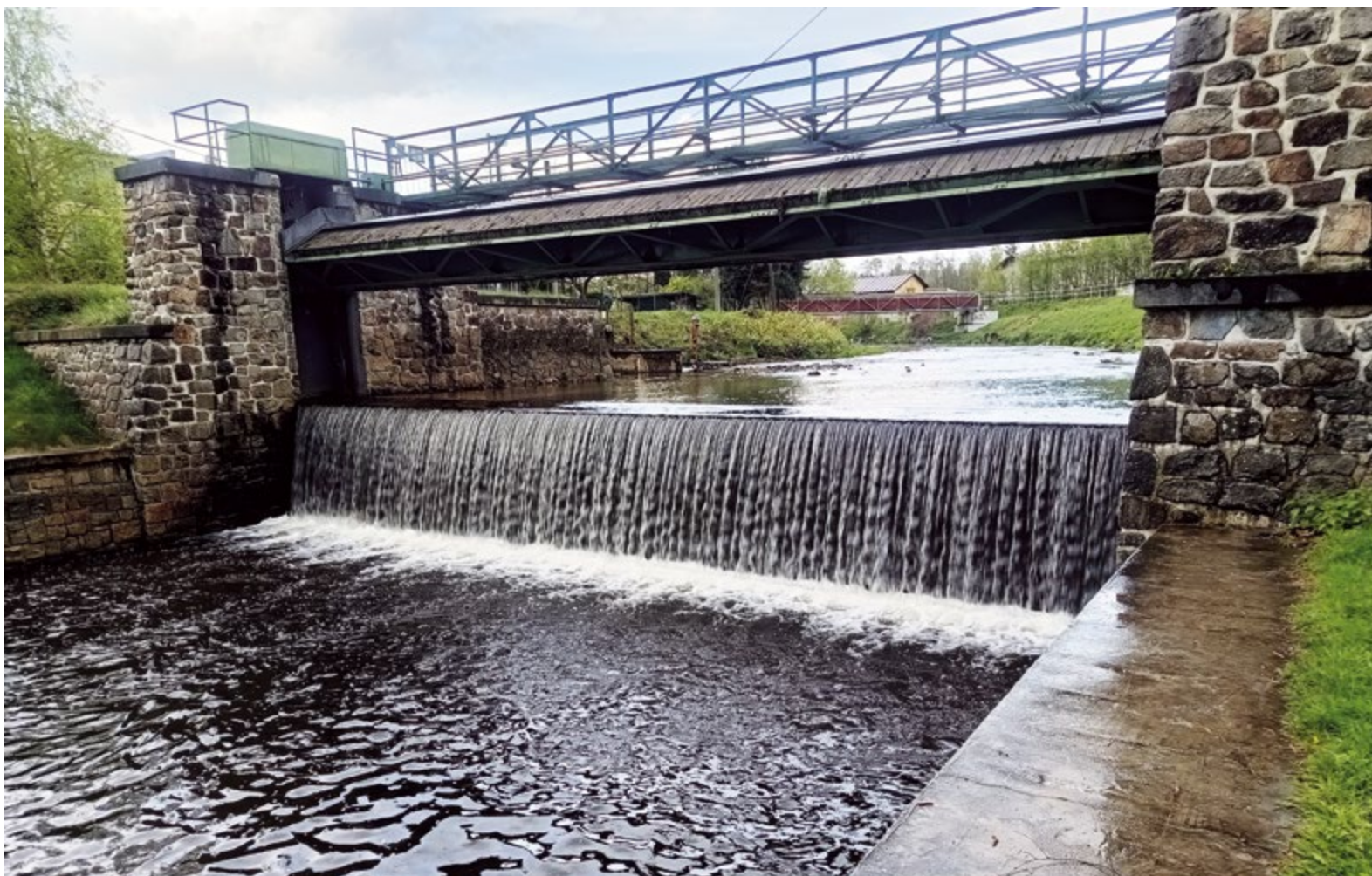
Obr. 3. Současný stav pevného jezu s pohyblivou tabulí v Rybářích na ř. km 1,1 (foto: E. Bouše)
