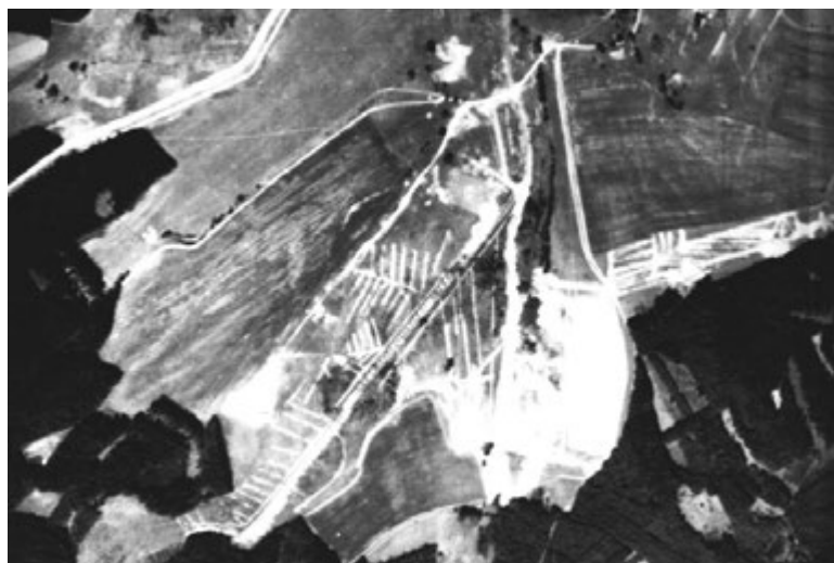
Obr. 8. Historický letecký snímek budování odvodňovacích systémů na Ašsku v okolí obce Pastviny
