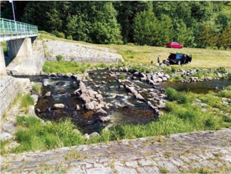
Obr. 6. Revitalizovaný jez na ř. km 9,2 v Nové Roli (foto: E. Bouše) Fig. 6. Restored weir in Nová Role at river km 9.2 (photo: E. Bouše)
