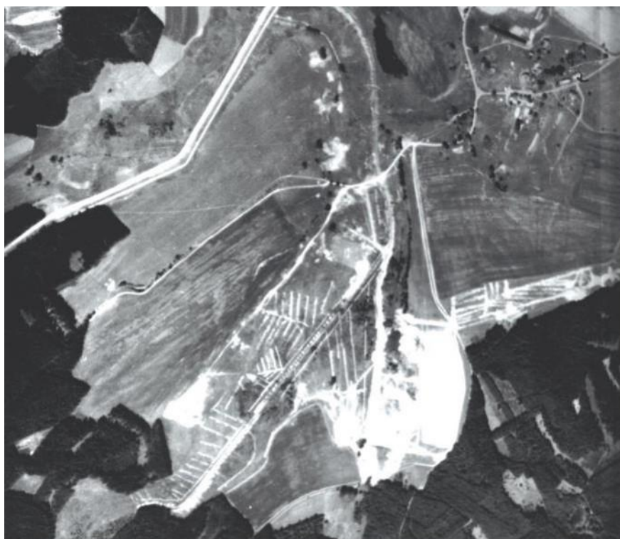
Obr. 8. Historický letecký snímek budování odvodňovacích systémů na Ašsku v okolí obce Pastviny
