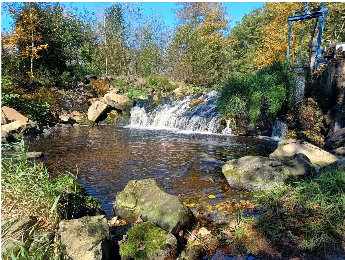
Obr. 4. Jez ve Staré Roli na ř. km 4,6 – konstrukce z balvanů zalitých betonem (foto. E. Bouše)
