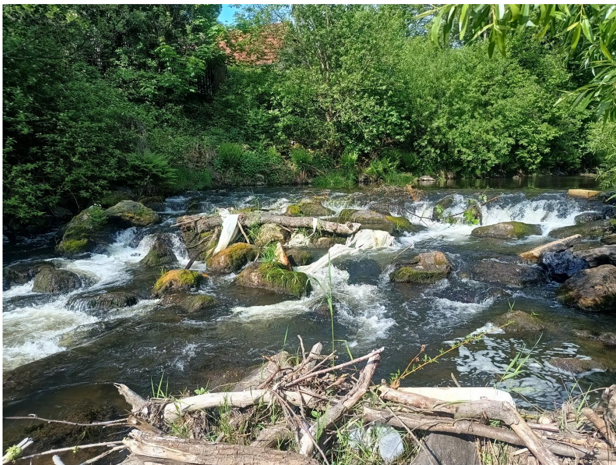
Obr. 5. Jez v Karlových Varech na ř. km 1,5 – příklad migrační překážky s narušenou konstrukcí (foto: E. Bouše)
