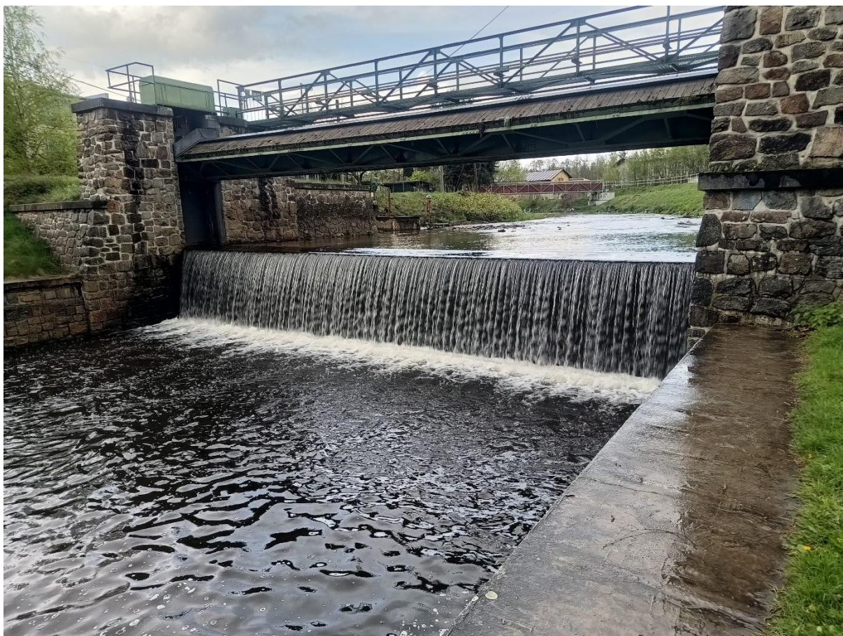
Obr. 3. Současný stav pevného jezu s pohyblivou tabulí v Rybářích na ř. km 1,1 (foto: E. Bouše)
