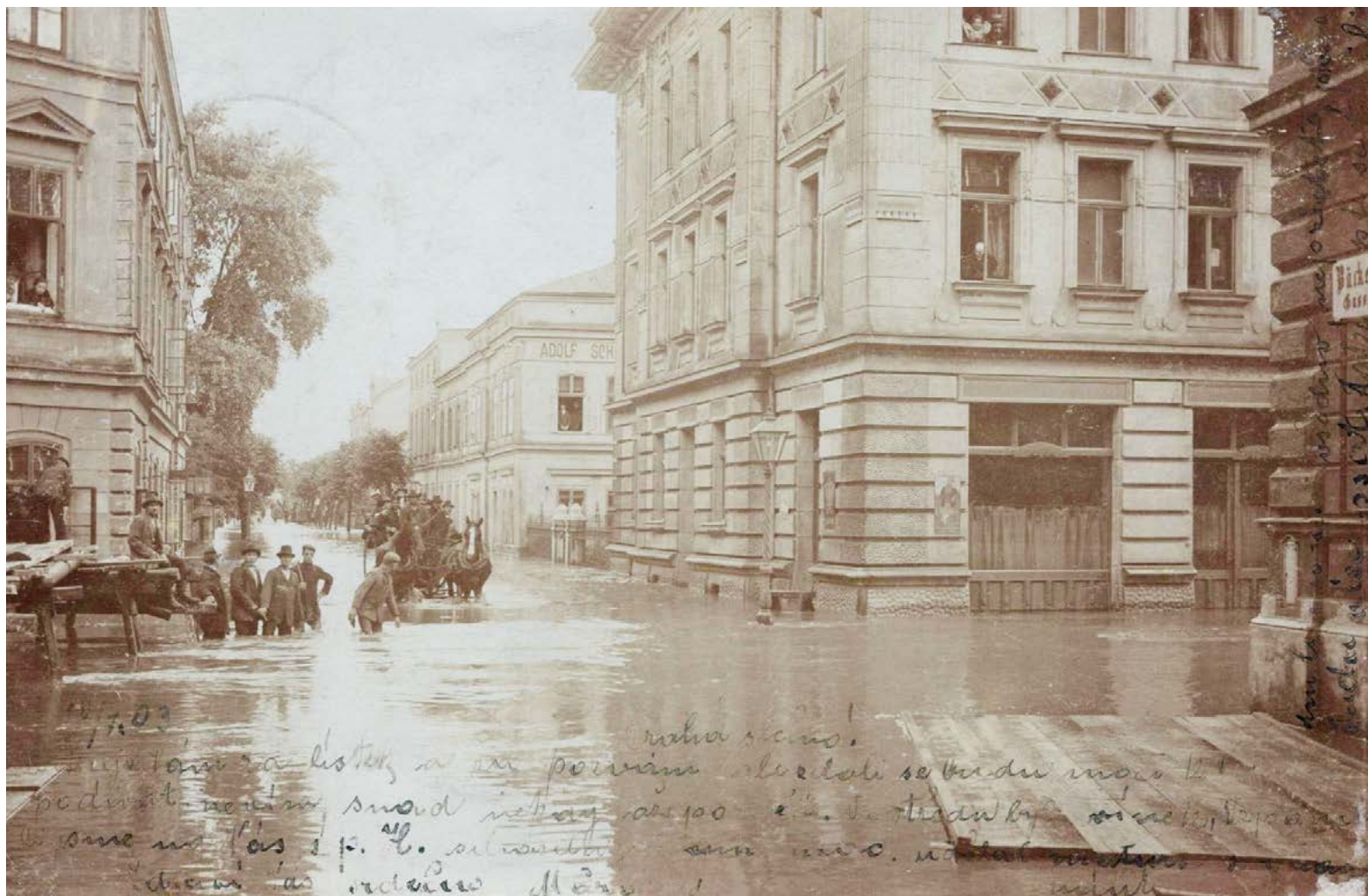
Obr. 2. Foto z povodně 1903 v prostoru Pekařské ulice (zdroj: Zemský archiv Opava, číslo archiválie cz227205010/1062/1/2/1/1/2//23+43)
