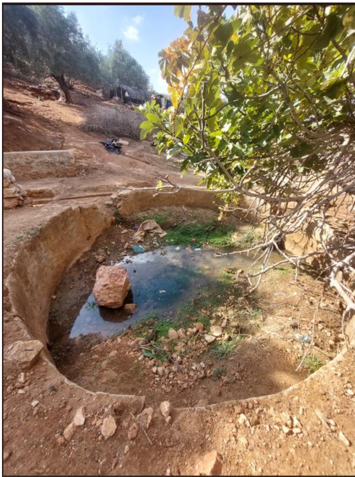
Obr. 5. Starověká cisterna ve středním Maroku (zdroj: autoři)
