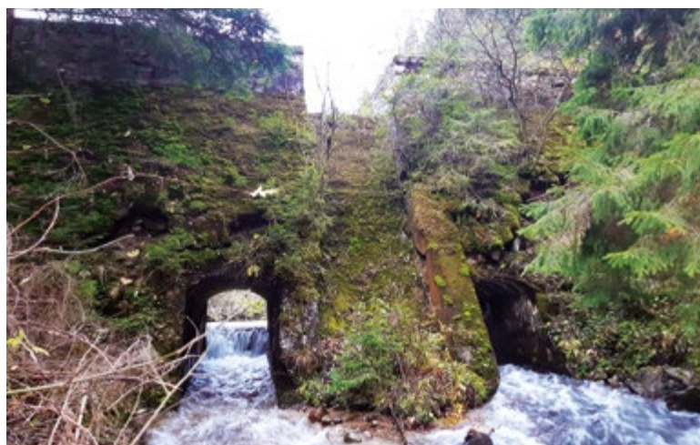
Obr. 14. Relikty výpustných štôlní v hrádzi klauzy Magurka v novembri 2025 Fig. 14. Relics of outlet galleries of Magurka splash dam, November 2025
