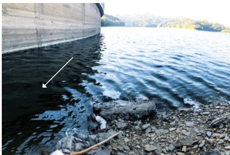
Obr. 8. Nádrž Vír (lokalita č. 43), pohled na hráz a odběrové místo Fig. 8. Vír reservoir (site no. 43), view of the dam and sampling site
