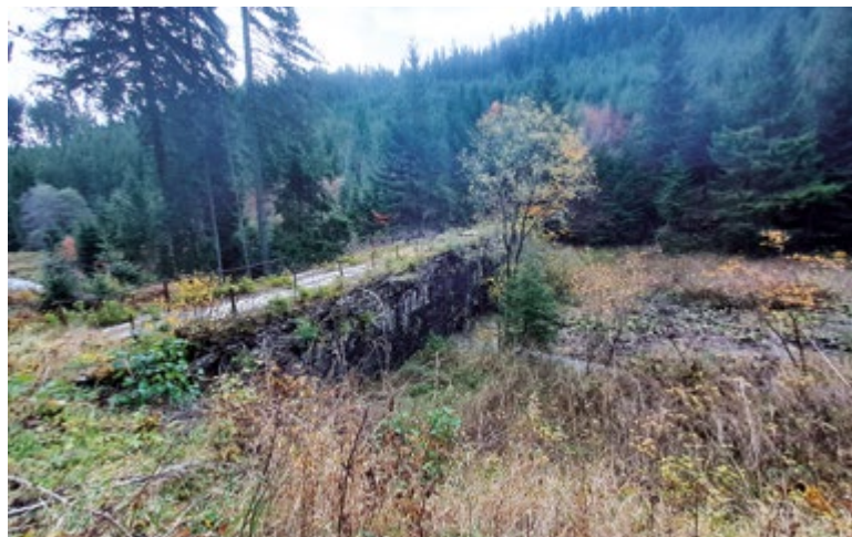
Obr. 13. Vodná strana hrádze klauzy Magurka v novembri 2025 Fig. 13. Upstream slope of Magurka splash dam, November 2025
