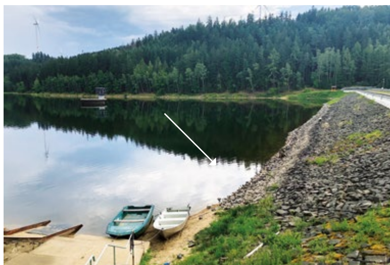
Obr. 4. Nádrž Horka (lokalita č. 19), pohled na hráz a odběrové místo Fig. 4. Horka reservoir (site no. 19), view of the dam and sampling site
