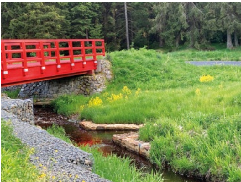
Obr. 6. Blatenský vodní příkop s čerstvě opravenou lávkou (červen 2025)
