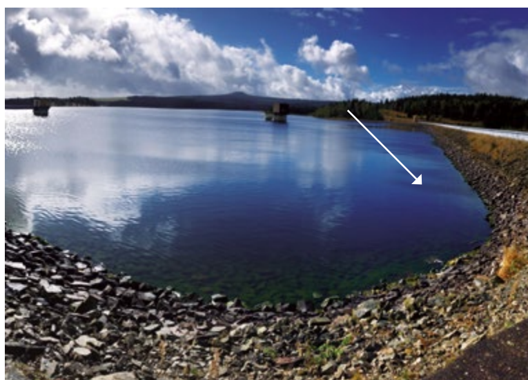
Fig. 3. Příšečnice reservoir (site No. 28), view of the dam and sampling site
