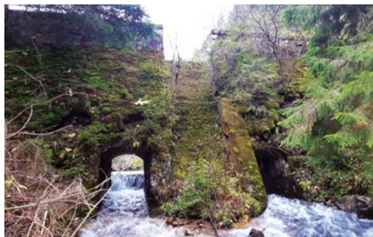
Obr. 14. Relikty výpustných štôlní v hrádzi klauzy Magurka v novembri 2025
