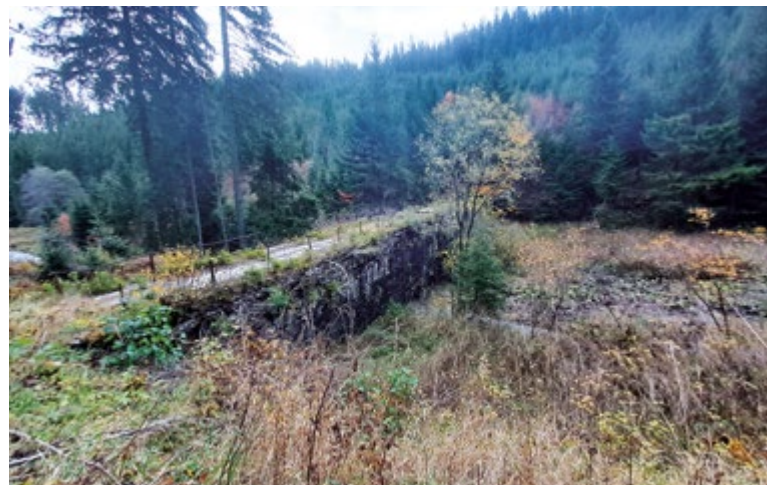
Obr. 13. Vodná strana hrádze klauzy Magurka v novembri 2025
