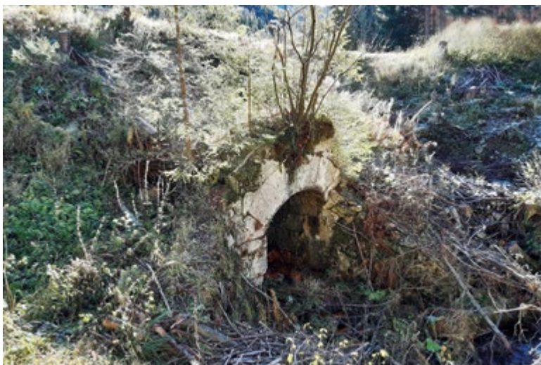
Obr. 9. Portál nefunkčnej výpusťnej štolíne zachovaný v hrádzi kluazy Malužiná v novembri 2025 Fig. 9. Portal of a disused outlet gallery preserved in the embankment of Malužiná splash dam, November 2025
