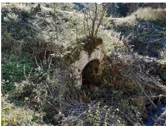
Obr. 9. Portál nefunkčnej výpustnej štôlne zachovaný v hrádzi klauzy Malužiná v novembri 2025 Fig. 9. Portal of a disused bottom outlet preserved in the Malužiná slosh dam in November 2025
