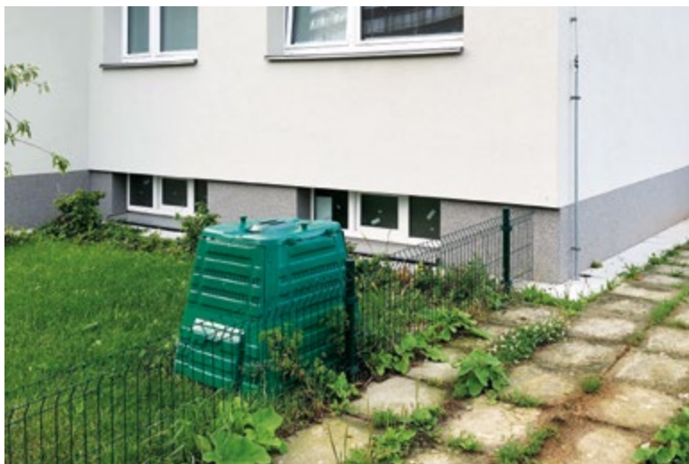
Obr. 4. Kompostéry dnes můžeme vidět nejen u rodinných domů, ale čím dál více je využívají také obyvatelé panelových domů na sídlištích (foto: archiv autorů) Fig. 4. Today, we can see composters not only in family houses, but they are also increasingly used by residents of panel houses in housing estates (photo: authors' archive)
