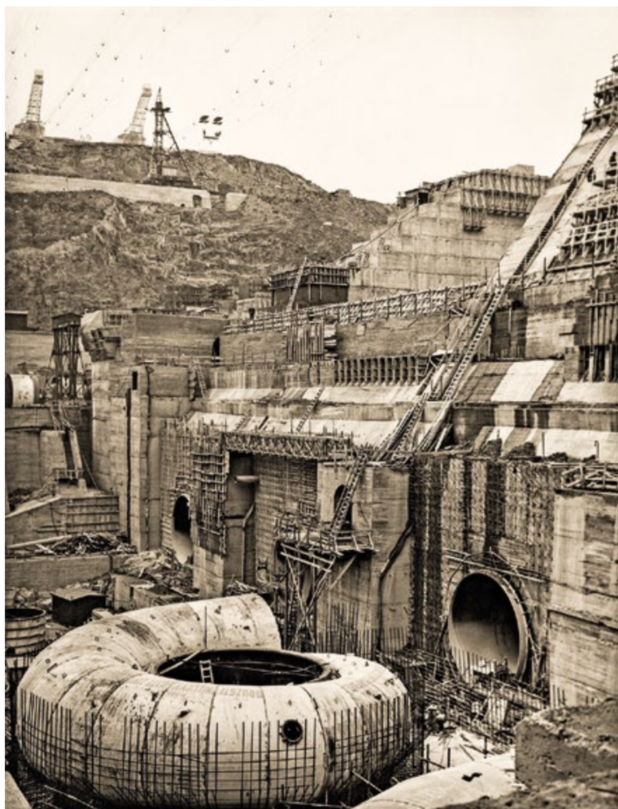
Vodní dílo Orlík je v řetězu vltavských přehrad nejvyšší a nejmohutnější. Jeho 450 m dlouhá betonová hráz dosahuje v koruně výšky 91 m. Výzkumný ústav vodohospodářský modelovým výzkumem vyřešil tvar přelivu a vývaru. Modelově byly testovány i vlastnosti uzávěrů na vtocích do elektrárny a teplotní režim orlické nádrže. Ze stavby orlické přehrady (4. listopadu 1959)
