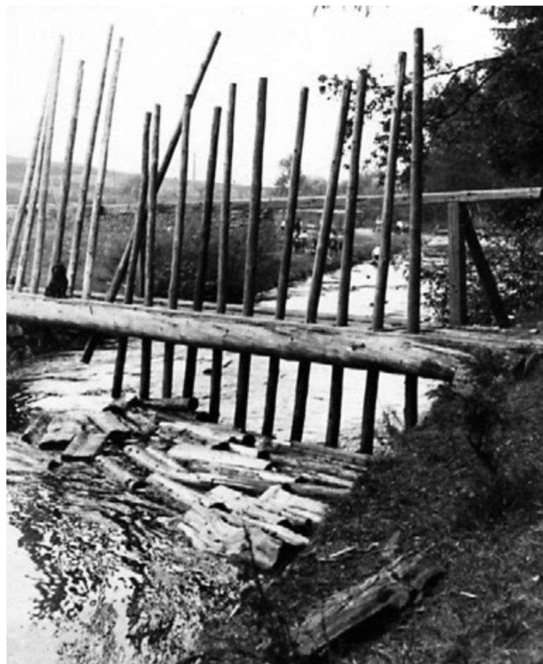
Fig. 5. Simple timber barrier, a so called rechle (from the German Rechen , meaning rake) (source: Roučka, Z. Předválečnou Šumavou. Život – práce – krajina . Plzeň, 2006)
