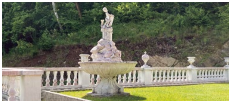
Obr. 18. Bohatě zdobené balustrády
