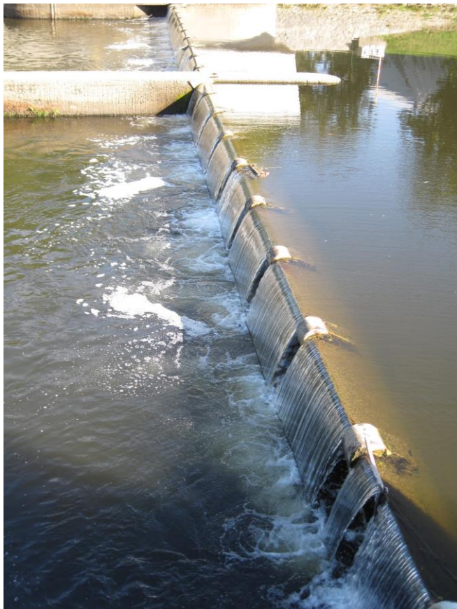
Obr. 2. Jez Strakonice Fig. 2. Strakonice weir
