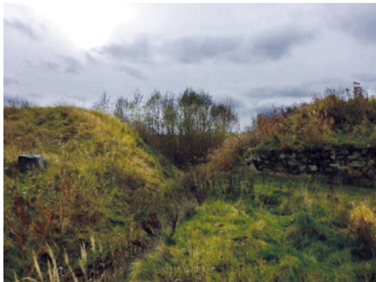
Obr. 6. Průrva v hrázi Mlékovičského rybníka a stav vegetace v prostoru zátopy čtyři roky po protřetí, stav v roce 2017 [20]
