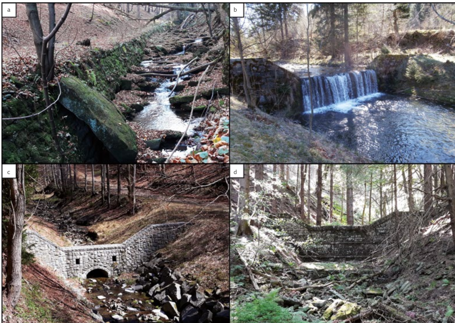
Obr. 7. Antropogenní diskonektivity vyskytující se v povodí Slavíče: a) staré opevnění břehu v horním úseku hlavního toku Slavíče; b) stabilizační stupeň ve spodní části hlavního toku Slavíče; c) retenční přehrážka vybudovaná na Ropičném potoce; d) stará retenční přehrážka v pramenné části hlavního toku Slavíče
