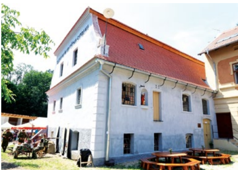
Fig. 3. Satran's Mill in Vepřek (Photo: R. Šimek, 2021)
