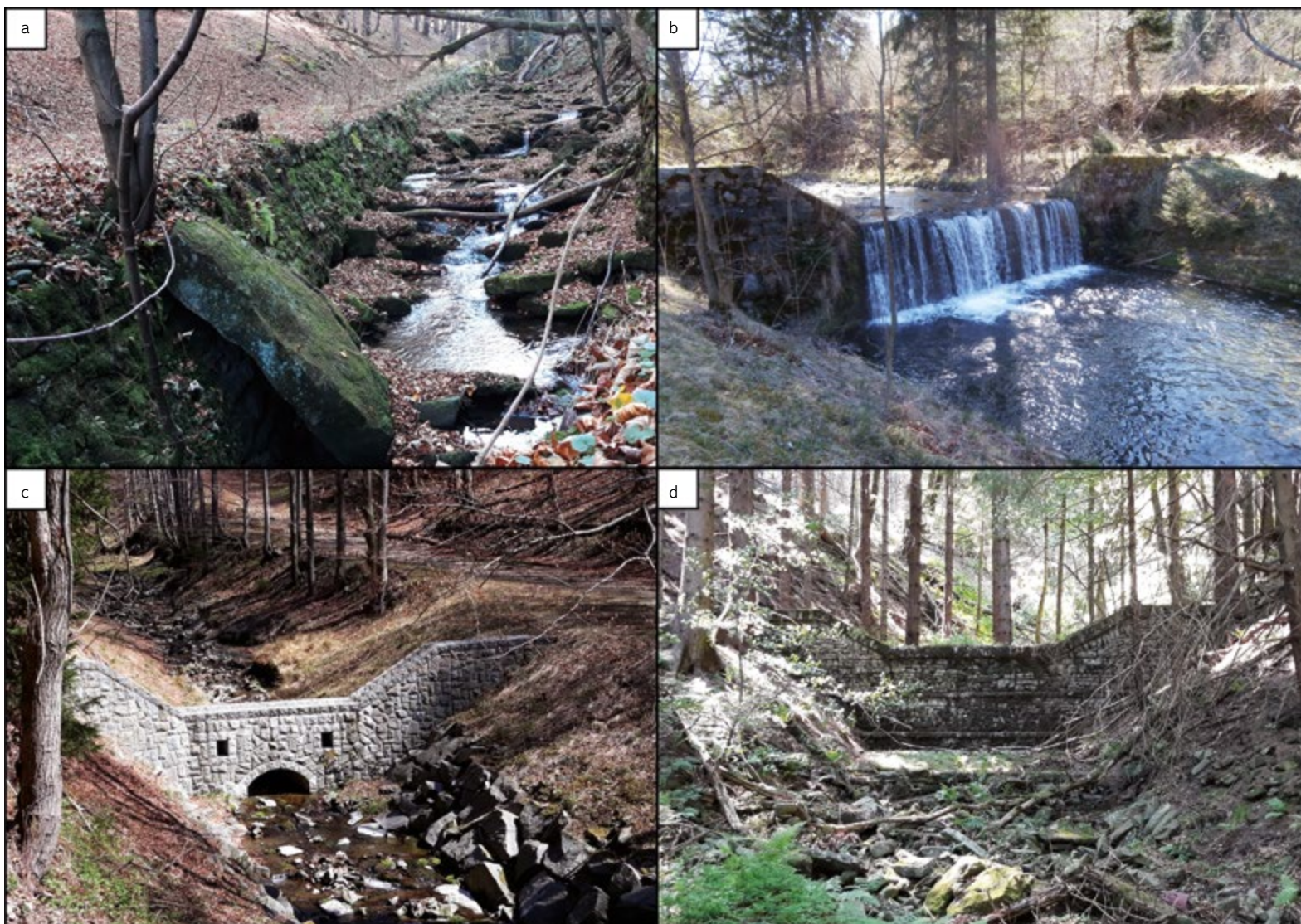
Obr. 7. Antropogenní diskonektivity vyskytující se v povodí Slaviče: a) staré opevnění břehu v horním úseku hlavního toku Slaviče; b) stabilizační stupeň ve spodní části hlavního toku Slaviče; c) retenční přehrážka vybudovaná na Ropičném potoce; d) stará retenční přehrážka v pramenné části hlavního toku Slaviče
