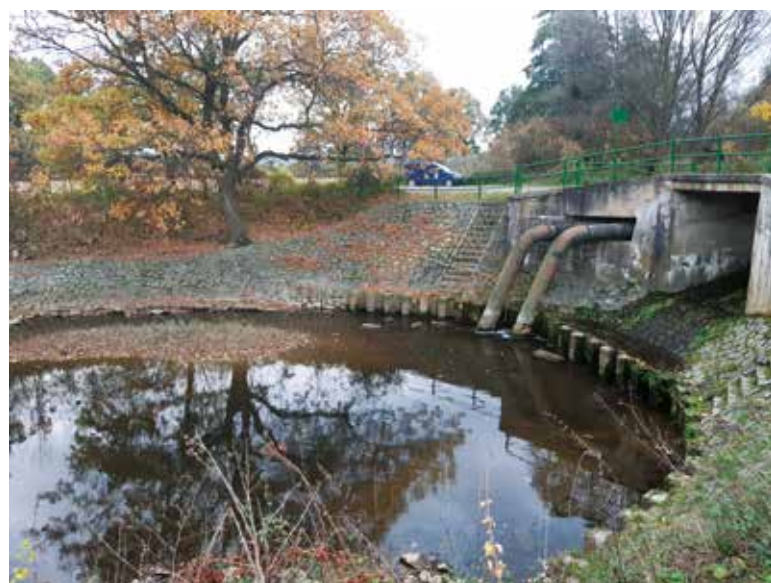
Obr. 8. Současná situace před jezem Bojmany u přepadu pro kanál, který sloužil pro napájení zaniklé rybníční soustavy a nyní se za jezem vrací zpět do Doubravy (listopad 2023)
