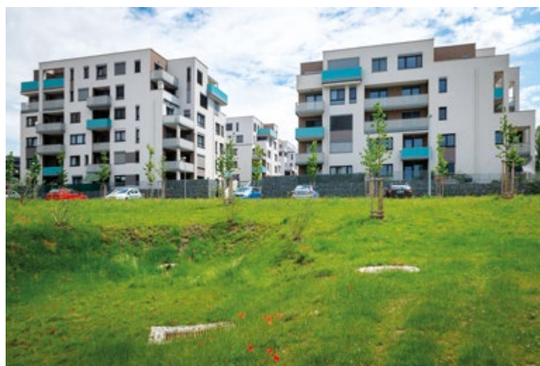
Obr. 2. Pod areálem Suomi Hloubětín se nacházejí vsakovací louky, kam putuje voda z retenčních nádrží (Zdroj: Nadace Partnerství – Adapterra Awards, foto: V. Herout)
