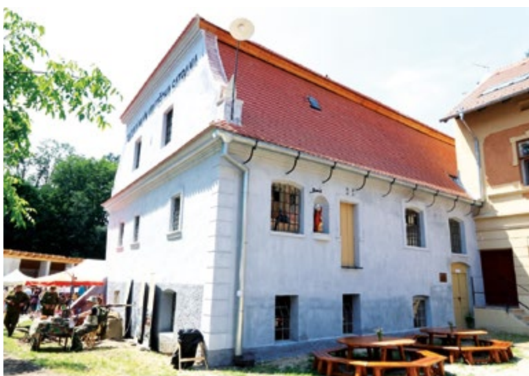
Fig. 3. Satran's Mill in Vepřek (Photo: R. Šimek, 2021)
