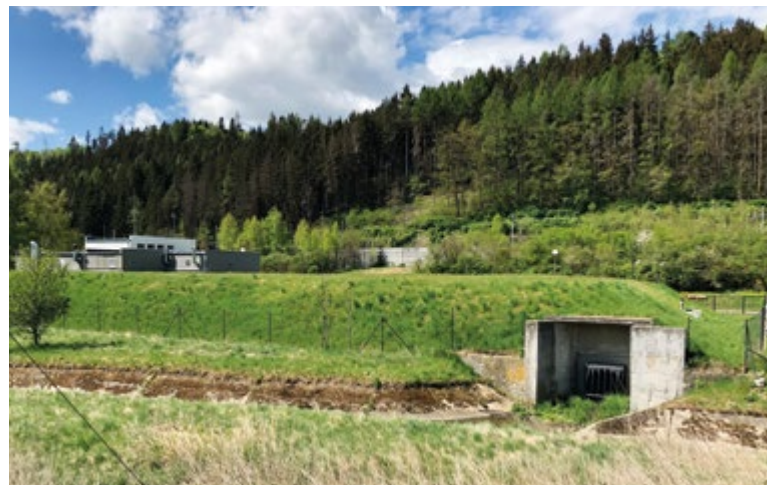
Obr. 5. Příklad zemního vodojemu u města Březová nad Svitavou (Foto: A. Létal, 5. května 2020)
