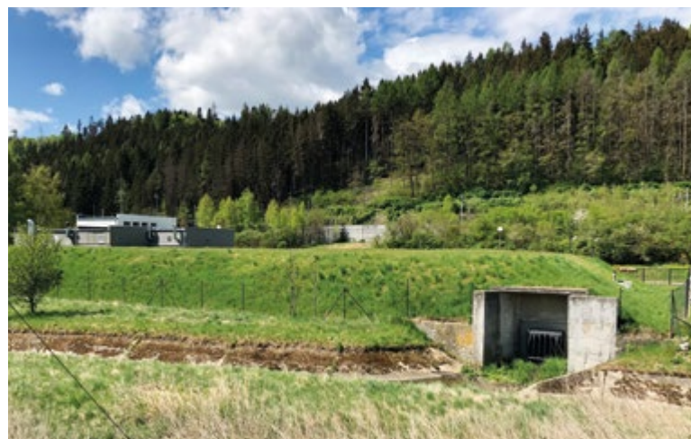
Obr. 5. Příklad zemního vodojemu u města Březová nad Svitavou (Foto: A. Létal, 5. května 2020)
