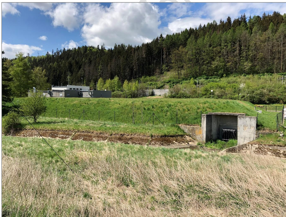
Obr. 5. Příklad zemního vodojemu u města Březová nad Svitavou (Foto: A. Létal, 5. května 2020)
