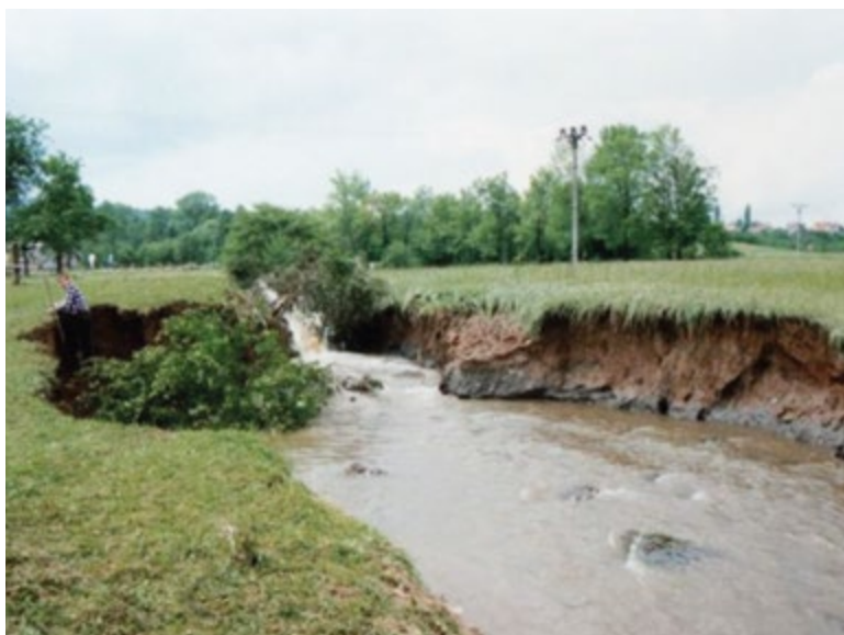
Obr. 1. Vývoj „výmolu – hrušky“ iniciovaného porušením spádového stupně při povodni (vlevo); schematické naznačení charakteru proudění v přechodové oblasti prostorového výmolu (vpravo) Fig. 1. Development of the “pear shaped” scour resulting from degradation of a drop structure on flash flood occurrence (left); feature of flow in transitional zone of the spatial 3D scour (right)
