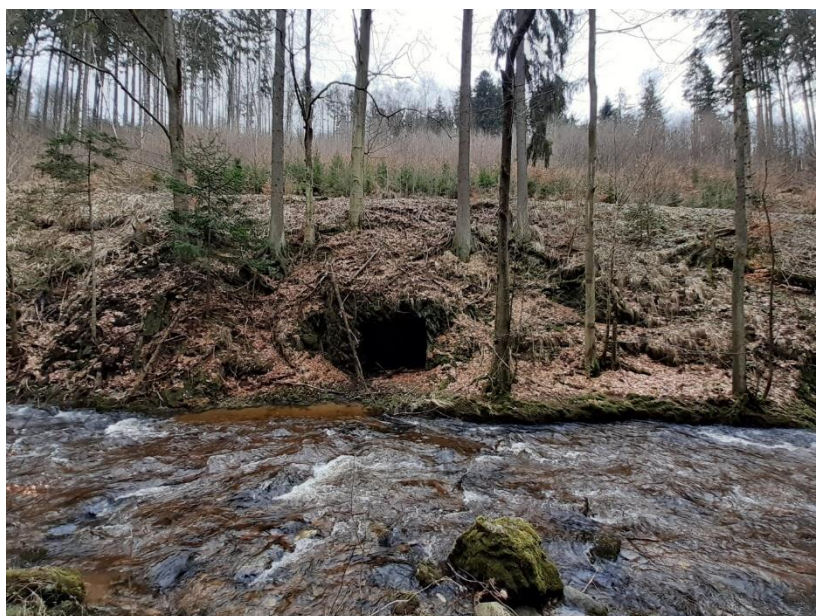
Obr. 3. Vyústění průzkumné štoly v údolí Zdobnice (LAPV Pěčín)
