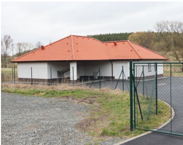
Obr. 2. Obec Ledce – ČOV 1 000 EO s kanalizací (Foto: T. Homola)
