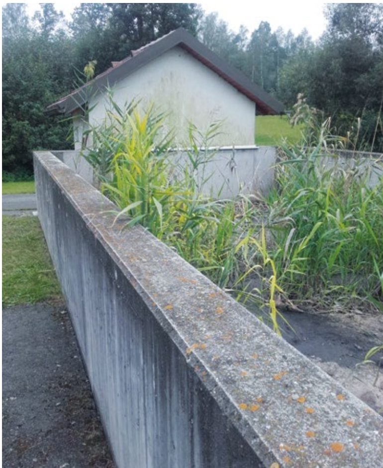
Obr. 2. RB jednotka pro vesnickou ČOV velikosti pod 200 EO, Rakousko
