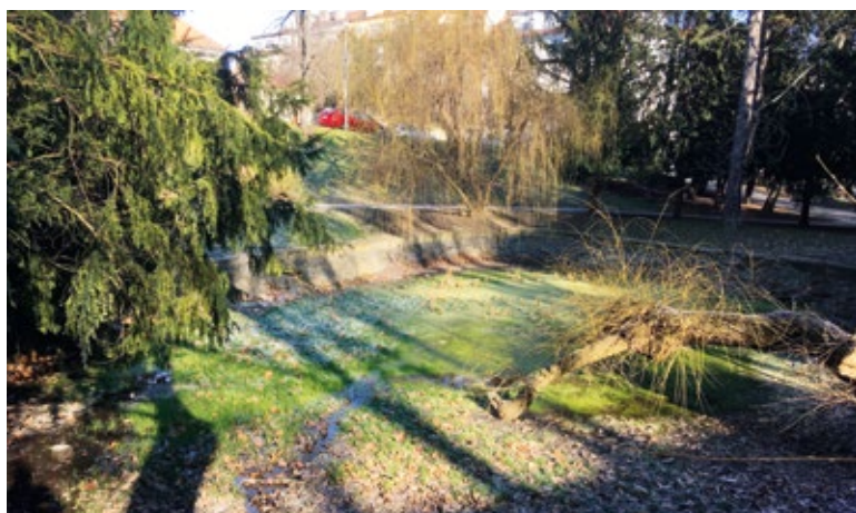
Obr. 10. Vyschlá a dlouhodobě nefunkční vodní nádrž v parku Jezerka
