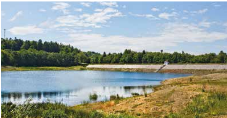
Fig. 5. Velká Richňava after reconstruction (Photo: S. Červeň)
