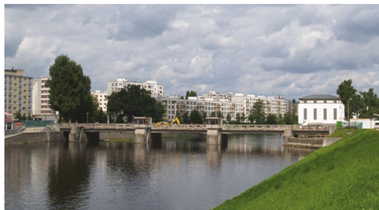
Fig. 11. Písek, cylindrical weir (Photo: J. Drozda, NPÚ, ÚOP České Budějovice)
