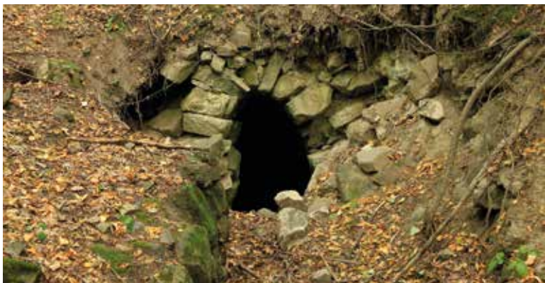
Fig. 3. Water tunnel (Photo: S. Červeň)
