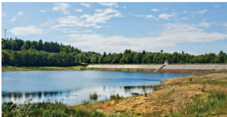
Obr. 5. Velká Richňava po rekonštrukcii (Foto: S. Červeň)
