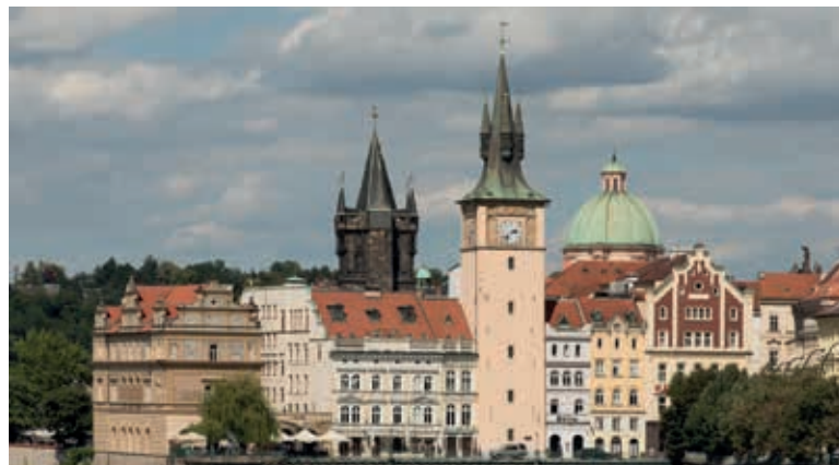
Obr. 1. Do panoramatu pravostranného nábřeží Vltavy neodmyslitelně patří vodárenská věž Staroměstské vodárny, která je zmiňována již v 15. století (Foto: R. Kořínek)
