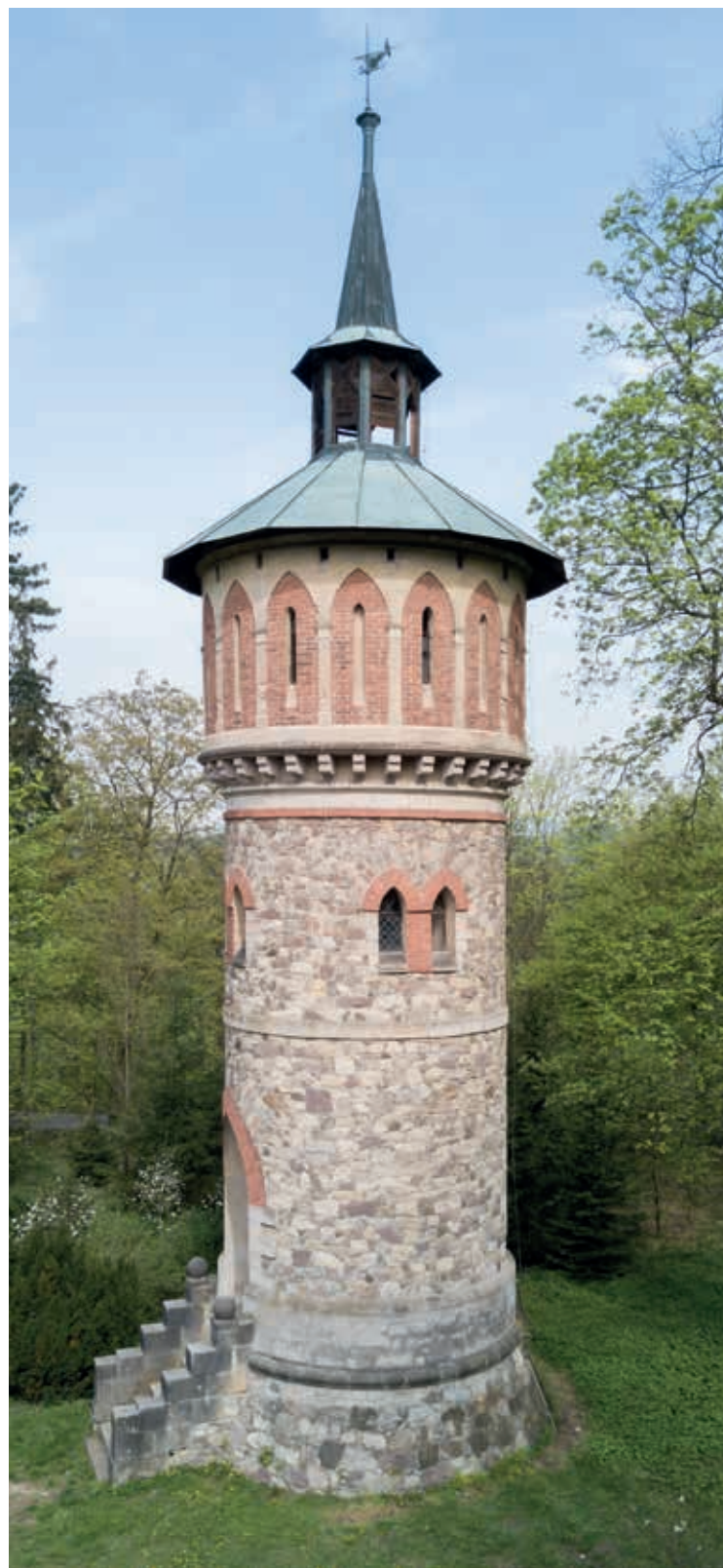
Obr. 20. Na zásobování vodou zámeckého parku sychrovského zámku se podílel také věžový vodojem, u něž bylo poprvé na našem území použito nosná konstrukce na kruhovém půdorysu (Foto: O. Cívín) Fig. 20. The water supply of the castle park of the Sychrov castle also took part in the elevated water tank, where a load-bearing structure on a circular plan was used for the first time in our territory (Photo: O. Cívín)
