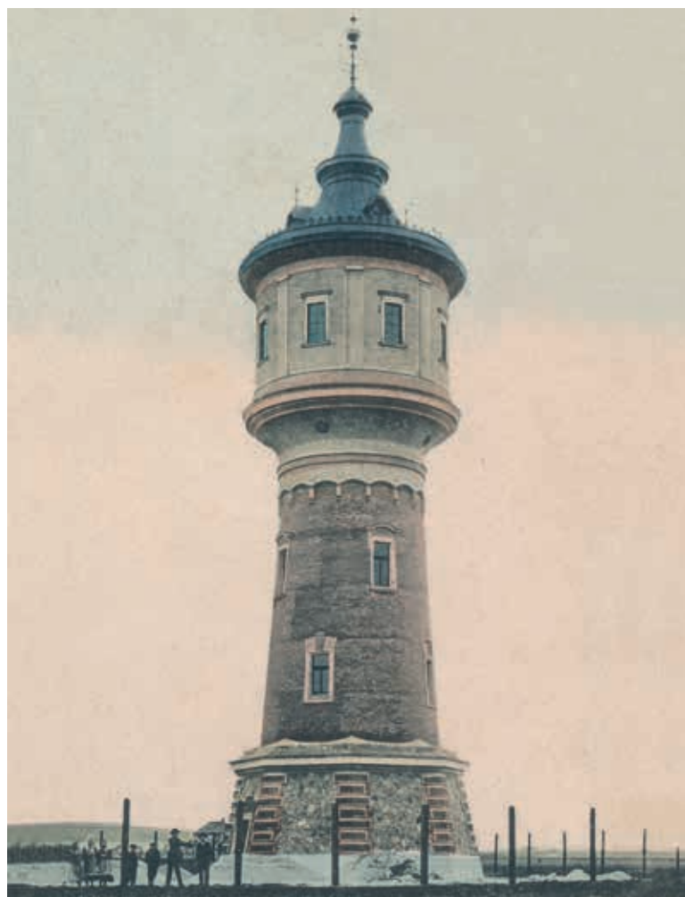
Obr. 5. Libeňský věžový vodojem z roku 1904 s charakteristickým rozšířením pláště kolem Intzeho nádrže (Archiv R. Kořínka)
