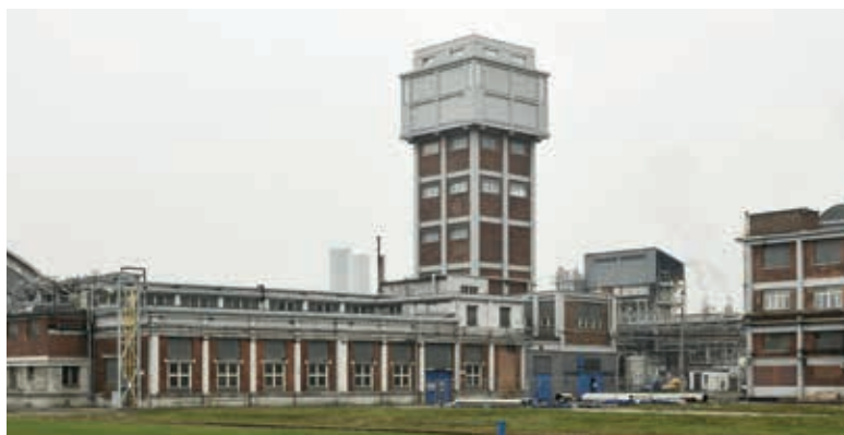
Obr. 15. Věžový vodojem v Ostravě-Mariánských Horách sjednocuje s okolními budovami železobetonový skelet s kombinací omítaných ploch, režného zdiva a motivů prolamování (Foto: R. Polášek)
