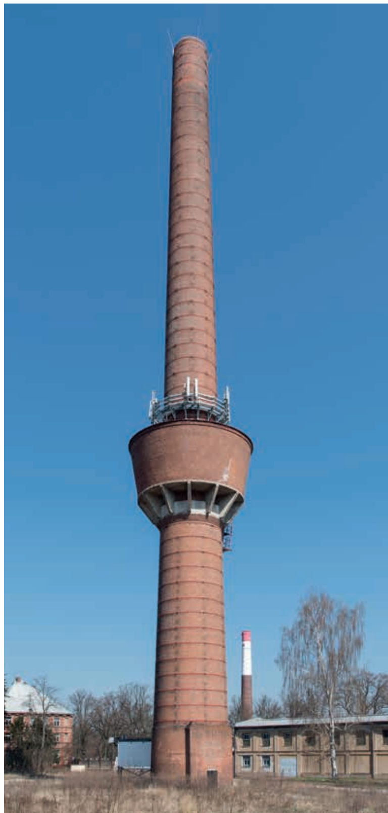
Obr. 16. Pro Mechanickou tkalcovnu a tiskárnu látek Josefa Sochora ve Dvoře Králové nad Labem byl roku 1942 postaven 80 metrů vysoký komín s železobetonovou nádrží o objemu 300 m 3 (Foto: M. Vonka)
