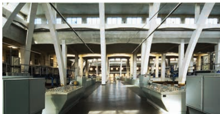
Obr. 3. Praha, úpravná vody v Podolí, hala filtrace, současný stav (Foto: Archiv PVK, 2018)
