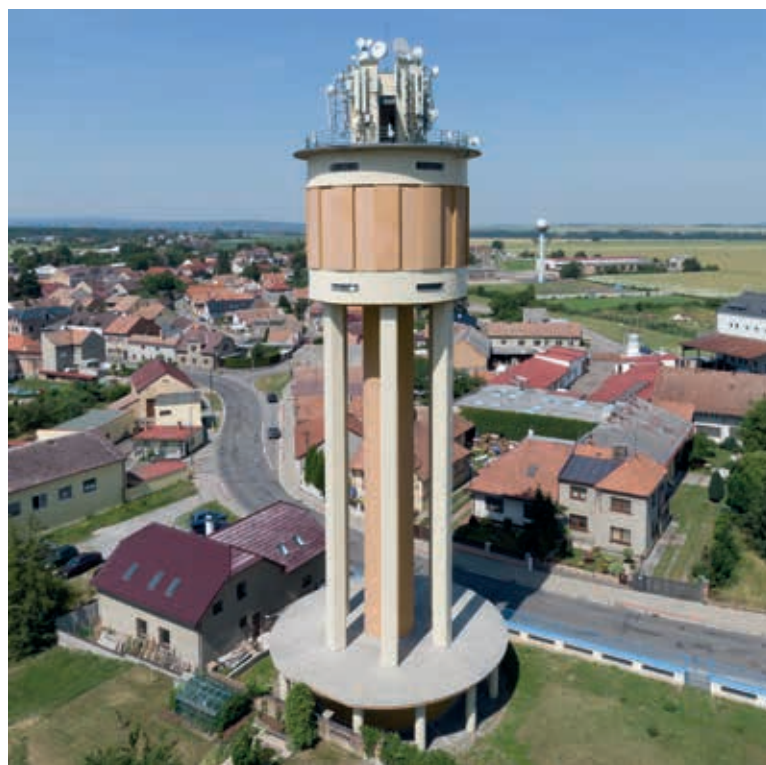
Obr. 9. Kombinovaná nosná konstrukce věžového vodojemu v Chrasti (Foto: O. Cívín) Fig. 9. Combined load-bearing structure of the elevated water tank in Chrasti (Photo: O. Cívín)
