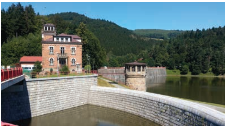
Obr. 5. Vodní dílo Bystřička dokončené v roce 1912, bezpečnostní přeliv Fig. 5. Bystřička dam completed in 1912, safety spillway
