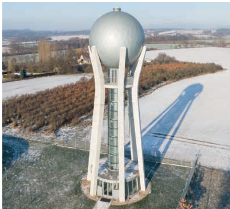
Obr. 23. Podoba věžového vodojemu v Ohrazenicích je důkazem, že pro tyto stavby má i v současné době smysl hledat originální a důstojná řešení (Foto: O. Cívín) [25]
