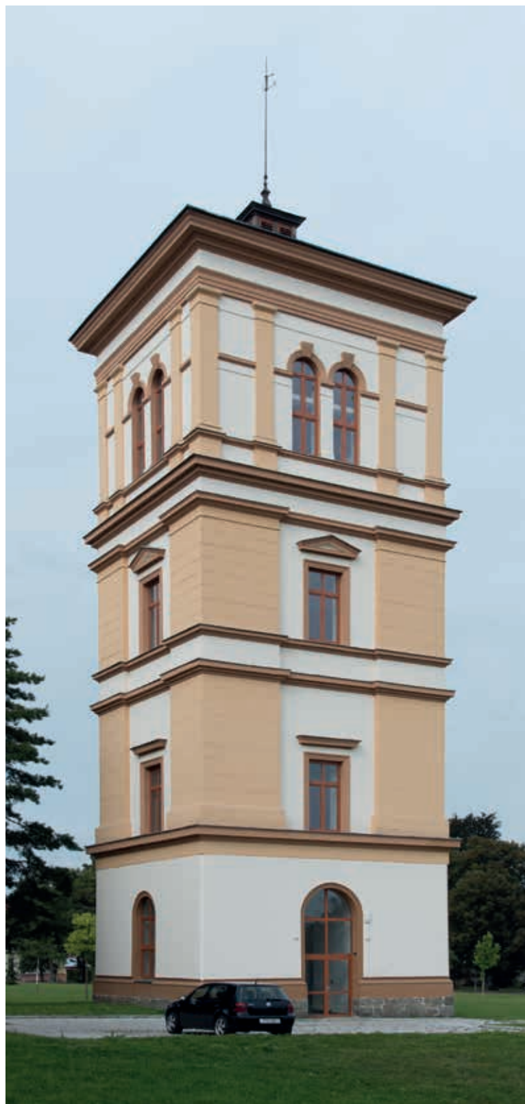
Obr. 18. Věžový vodojem léčebny v Dobřanech byl postaven v době výstavby areálu léčebny mezi lety 1876–1883 (Foto: R. Kořínek) Fig. 18. The elevated water tank of the sanatorium in Dobřany was built during the construction of the sanatorium area between 1876–1883 (Photo: R. Kořínek)
