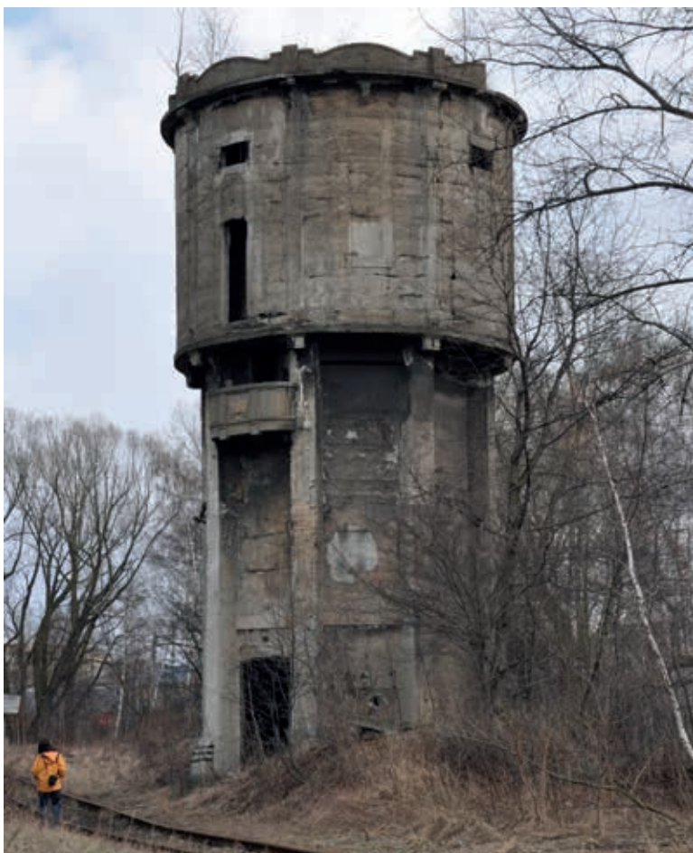
Obr. 3. Bohumínský věžový vodojem je první doloženou ukázkou užití železobetonu pro tyto stavby na železnici (Foto: R. Kořínek)
