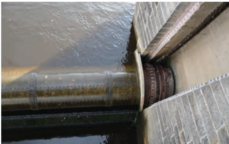
Obr. 9. Písek, válcový jez, detail (Foto: J. Drozda, NPÚ, ÚOP v Českých Budějovicích) Fig. 9. Písek, cylindrical weir, detail (Photo: J. Drozda, NPÚ, ÚOP České Budějovice)
