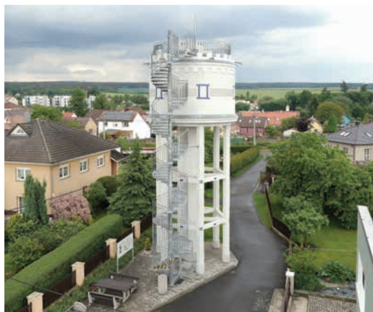
Obr. 13. Železobetonový věžový vodojem v Heřmanově Huti – Dolních Sekyřanech byl přebudován na rozhlednu a je přístupný veřejnosti (Foto: O. Cívín) Fig. 13. The reinforced concrete elevated water tank in Heřmanova Huť – Dolní Sekyřany was rebuilt into a lookout tower and is open to the public (Photo: O. Cívín)
