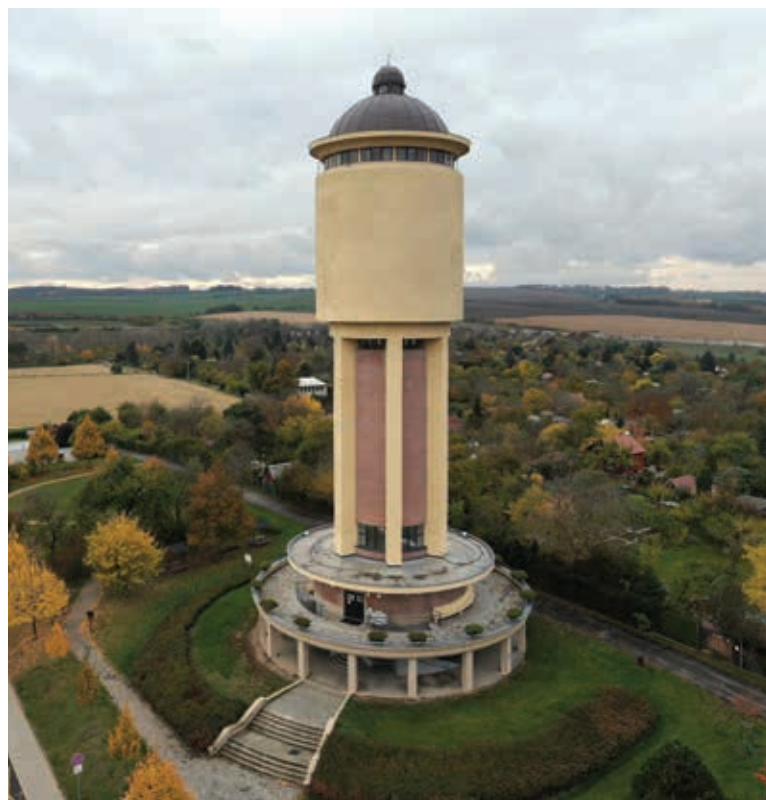
Obr. 8. Věžový vodojem v Kolíně navržený architektem Františkem Jandou ve funkcionalistickém stylu (Foto: O. Cívín) Fig. 8. Elevated water tank in Kolín designed by architect František Janda in functionalist style (Photo: O. Cívín)
