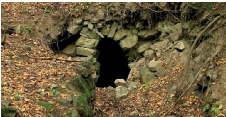
Obr. 3. Vodná štôlna (Foto: S. Červeň)
