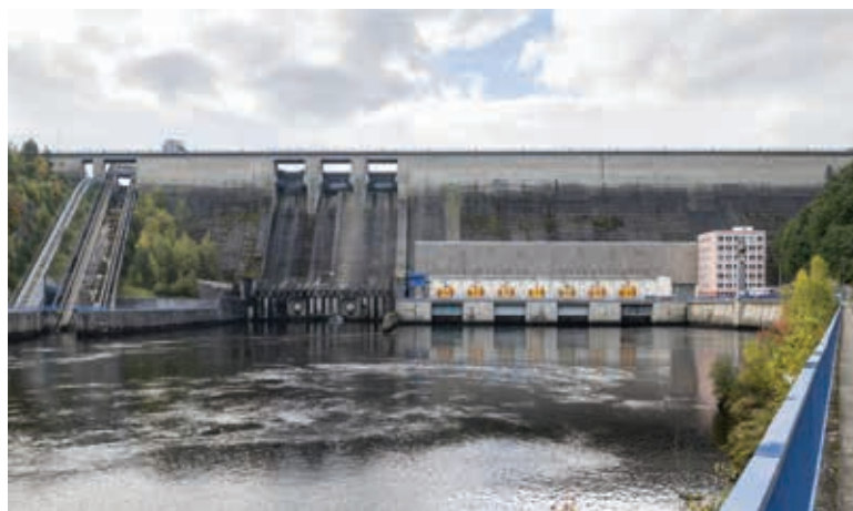
Obr. 6. Vodní dílo Orlík, betonová tížní hráz dokončená v roce 1960 (Foto: V. Macha, 2021) Fig. 6. Orlík waterworks, a concrete gravity dam completed in 1960 (Photo: V. Macha, 2021)
