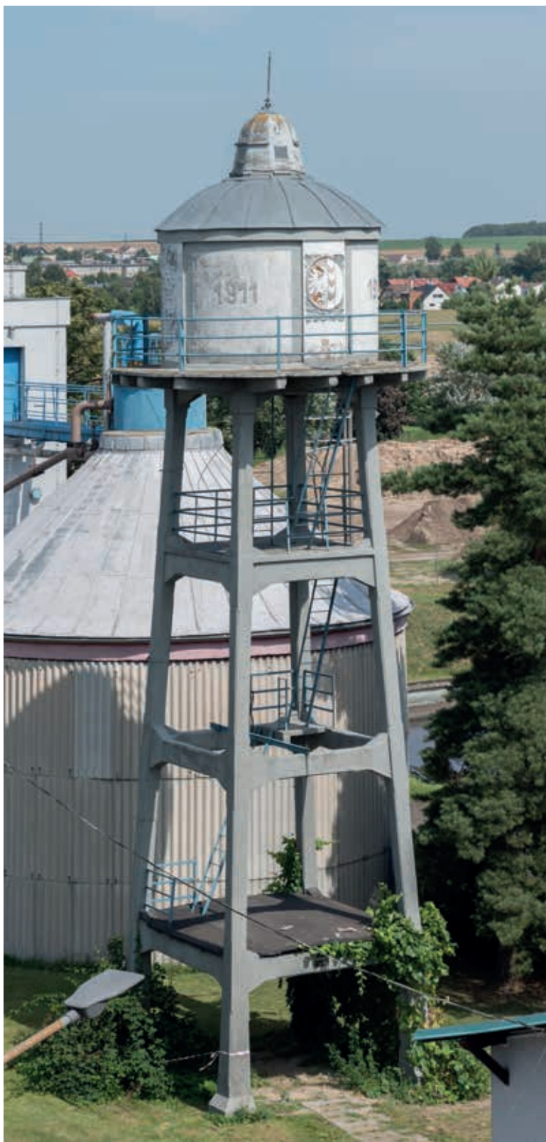
Obr. 19. Pro stavbu věžového vodojemu opavské čistírny odpadních vod bylo poprvé na našem území použito otevřená železobetonová nosná konstrukce (Foto: R. Kořínek) Fig. 19. Open reinforced concrete supporting structures were used for the construction of the elevated water tank of the Opava wastewater treatment plant for the first time in our territory (Photo: R. Kořínek)
