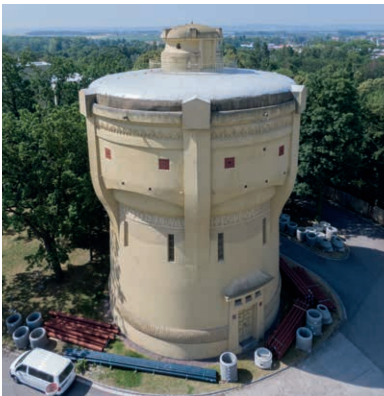
Obr. 7. Nejstarší dochovaný železobetonový věžový vodojem v městském prostředí byl postaven roku 1907 v Pardubicích (Foto: O. Cívín) Fig. 7. The oldest preserved reinforced concrete elevated water tank in an municipal environment was built in 1907 in Pardubice (Photo: O. Cívín)
