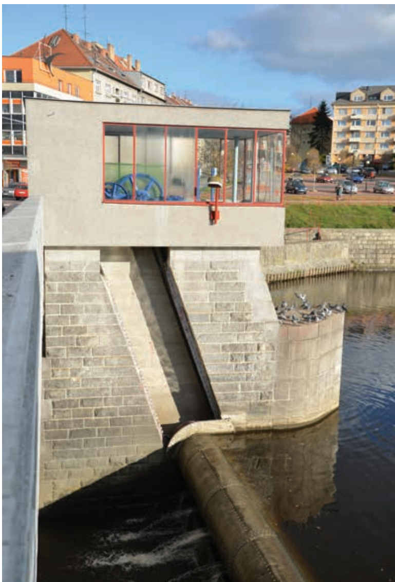
Obr. 10. Písek, válcový jez (Foto: J. Drozda, NPÚ, ÚOP v Českých Budějovicích) Fig. 10. Písek, cylindrical weir (Photo: J. Drozda, NPÚ, ÚOP České Budějovice)
