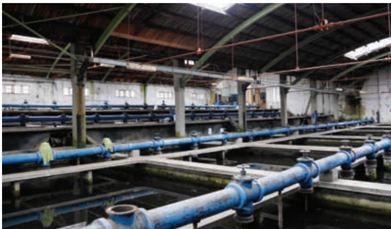
Obr. 14. Plzeň, Puech-Chabalova filtrace, interiér (Foto: M. Ryšková, 2019)
