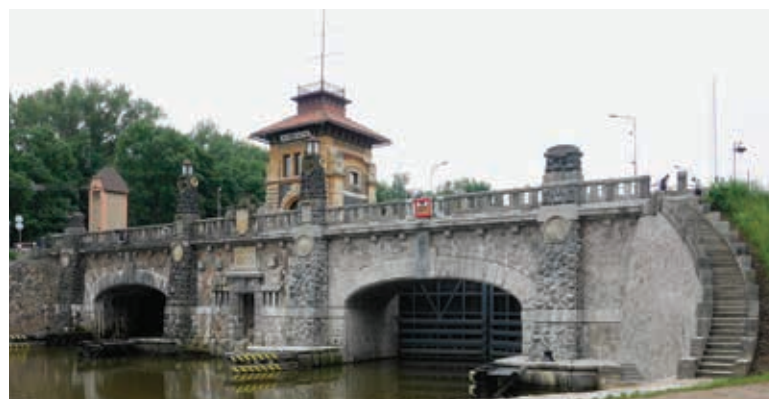
Obr. 7. Hořín, zdymadlo, stav po úpravě pravé velké plavební komory a výměně mostu nad ní (Foto: M. Ryšková, 2021)
