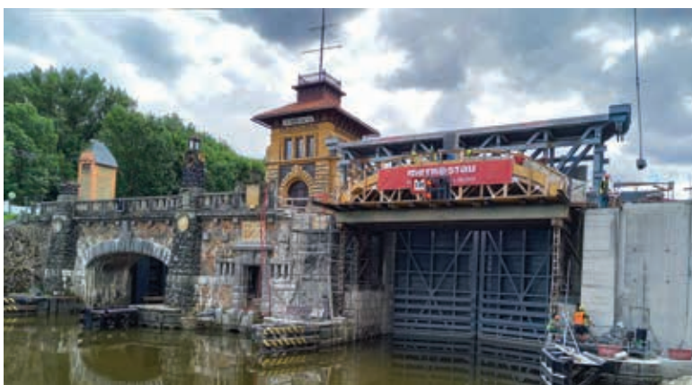
Obr. 6. Hořín, zdymadlo, nový zvedací most (Foto: O. Hrdlička, 2021) Fig. 6. Hořín, lock, new raising bridge (Photo: O. Hrdlička, 2021)
