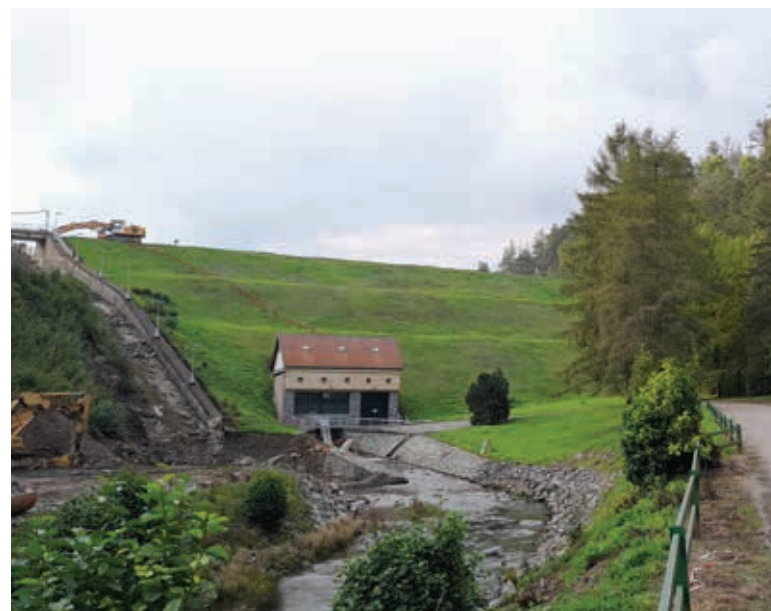
Obr. 7. Vodní dílo Letovice, sypaná hráz dokončená v roce 1976. Stav v době oprav bezpečnostního přelivu v roce 2022 (Foto: M. Forejtníková) Fig. 7. Letovice waterworks, an example of a bulk dam completed in 1976. The state at the time of the safety spillway repairs in 2022 (Photo: M. Forejtníková)
