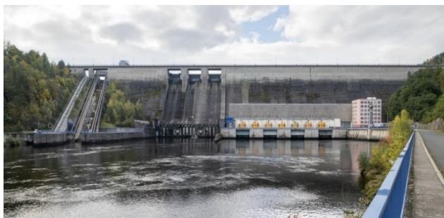
Obr. 6. Vodní dílo Orlík, betonová tížní hráz dokončená v roce 1960 (Foto: V. Macha, 2021)
