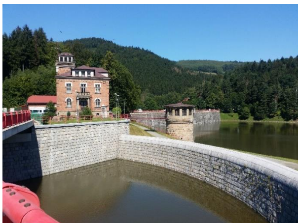
Obr. 5. Vodní dílo Bystřička dokončené 1912, bezpečnostní přeliv Fig. 5. Bystřička dam completed in 1912, safety spillway
