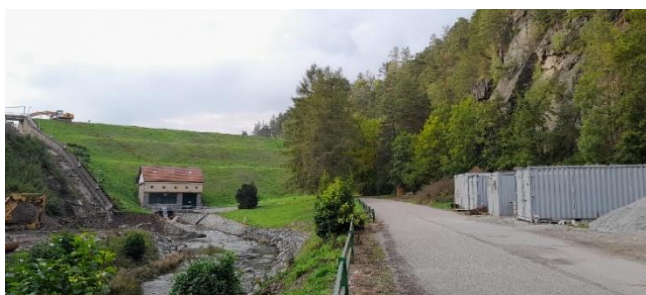
Obr. 7. Vodní dílo Letovice, sypaná hráz dokončená v roce 1976. Stav v době oprav bezpečnostního přelivu v roce 2022 (Foto: M. Forejtníková)
