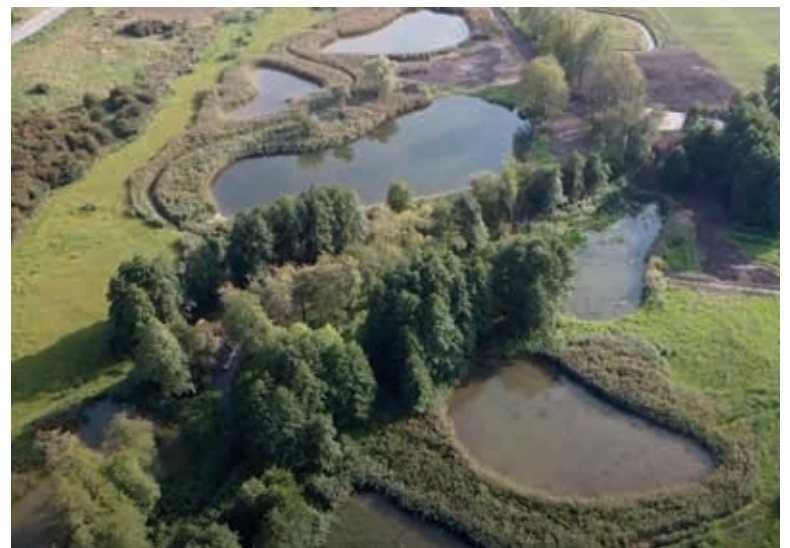
Obr. 4. Dokončená revitalizace, rok 2021 Fig. 4. Completed revitalization, 2021
