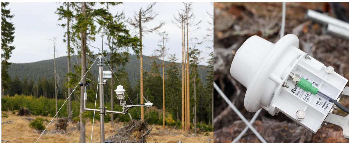
Obr. 1. Pohled na instalaci radarového srážkoměru a detail samotného senzoru WS100
