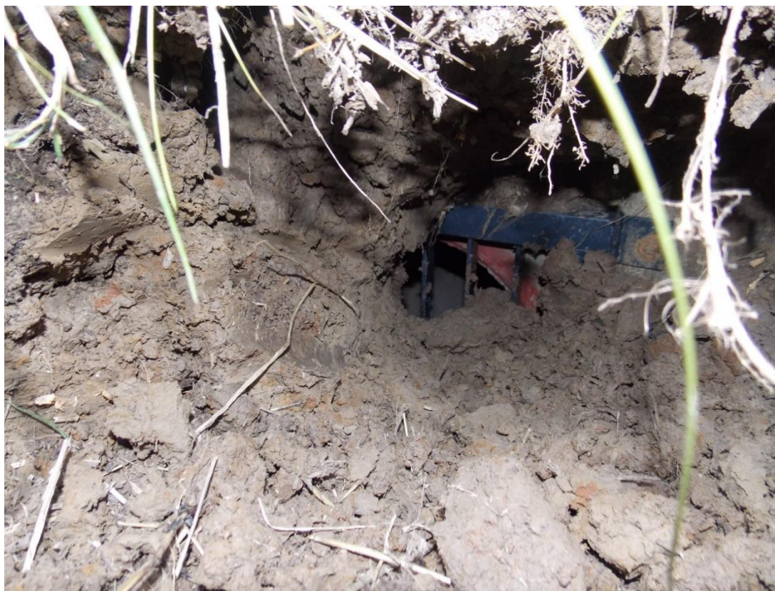
Obr. 7. Příklad zcela ucpaného nátoku do spodní výpusti SN – Polder N5 (AQUATIS, a. s.)
