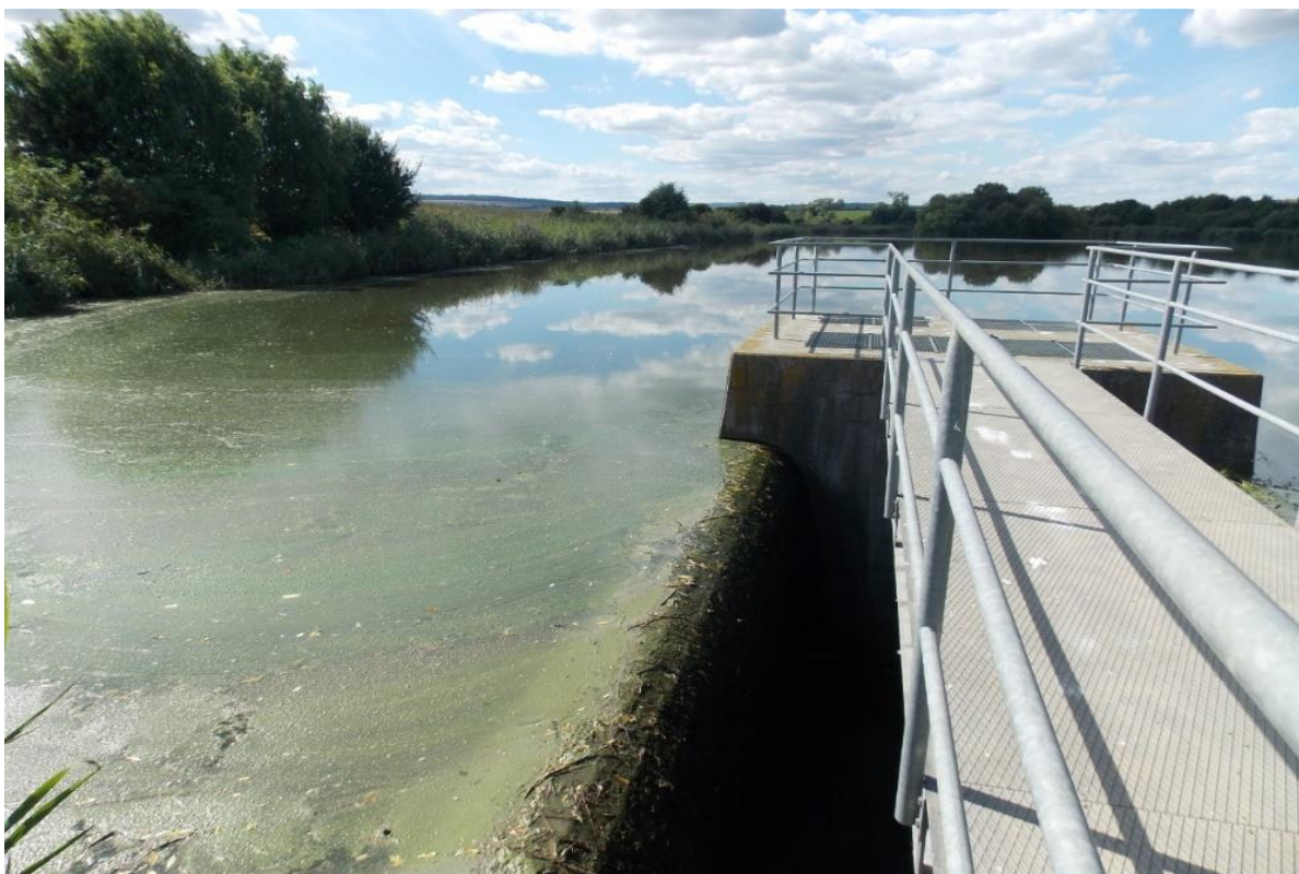
Obr. 9. SN Želeč je deklarována coby ochranná, ale provozována je jako zcela napuštěná (AQUATIS, a. s.)
