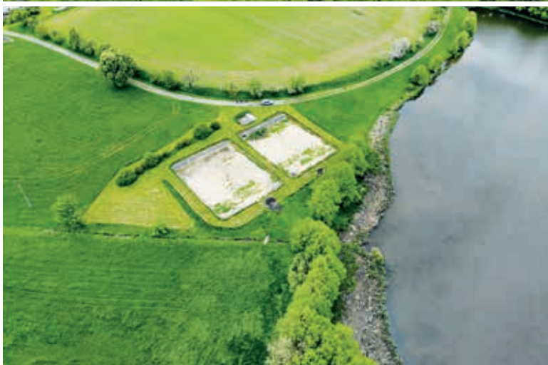
Obr. 1. Dva umělé mokřady v obci Zbenice, Česká republika
