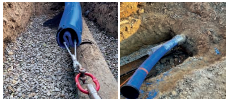
Obr. 11. Ukázka opravy přivaděče technologií close-fit, realizované firmou Vodohospodářský rozvoj a výstavba, a. s. [16]
