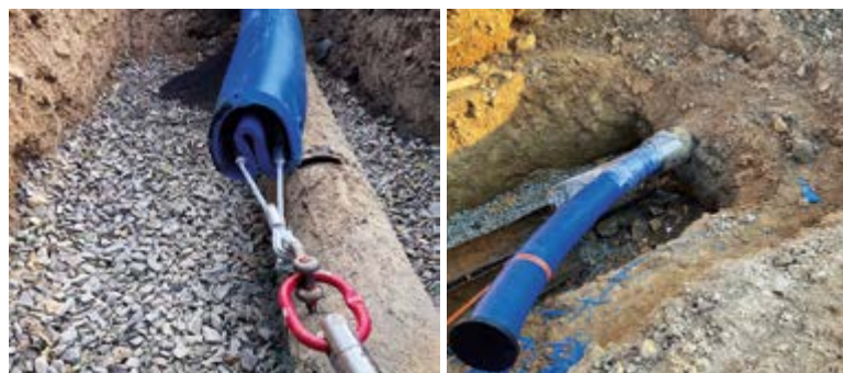
Fig. 11. Example of the repair of the feeder using close-fit technology, implemented by Vodohospodářský rozvoj a výstavba, a. s.
