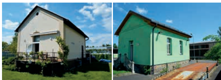
Obr. 8. Současný stav objektů studny II (vlevo) a studny III (vpravo) městské vodárny (Létal, květen 2021)
