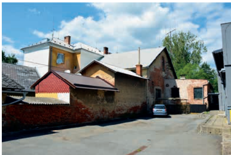
Obr. 9. Objekt bývalé městské vodní elektrárny s turbínovým domkem (vpravo); odtokový kanál je nyní zatrubněn (Létal, květen 2021)
