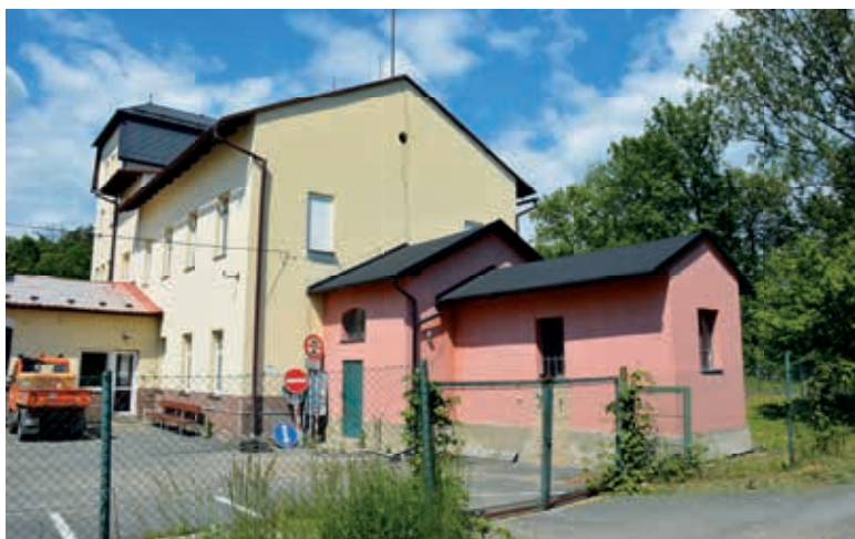
Obr. 4. Současná podoba bývalé vodárny se studnou (1), sekci pro elektrická čerpadla (2) a původní strojovnou (3) (Létal, květen 2021)
