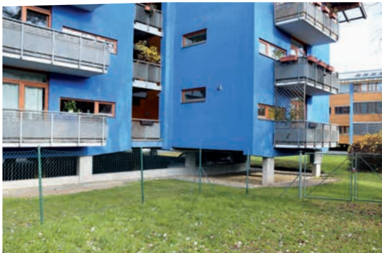
Obr. 5. Navýšené přízemí budov v rámci nové výstavby v záplavovém území Litovického potoka (Foto: VÚV TGM, v. v. i.)
