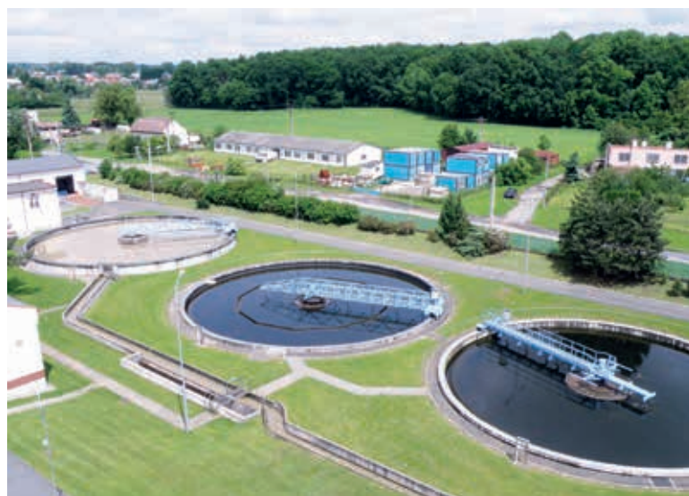
Obr. 3. Čistírna odpadních vod
