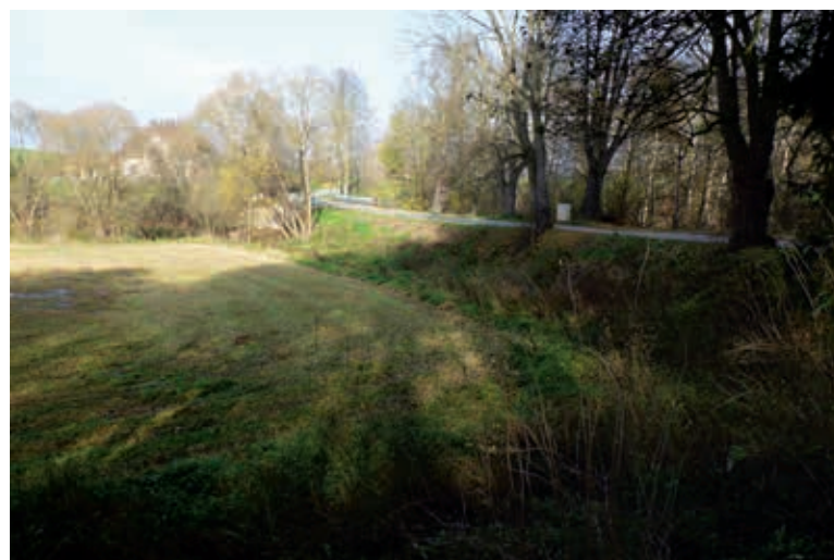
Obr. 5. Hráz bývalého Louňovického rybníka
