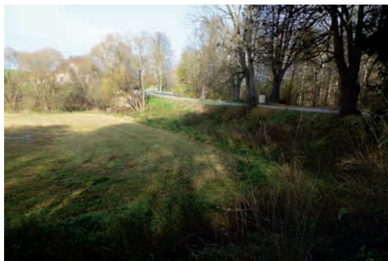
Obr. 5. Hráz bývalého Louňovického rybníka Fig. 5. Dam of former Louňovický fishpond
