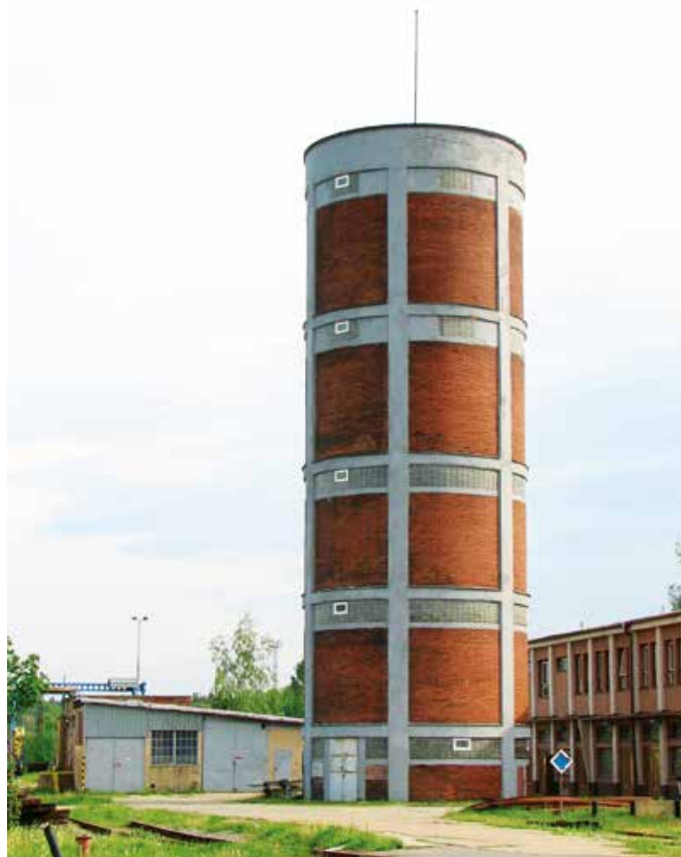
Obr. 2. Realizovaný věžový vodojem pro seřadovací nádraží (2012)
