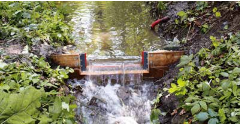
Obr. 1. Měrný přeliv osazený v terénu Fig. 1. Measuring weir situated in the stream
