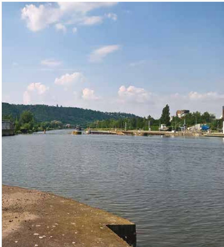
Obr. 5. Vltava-Modřany, jezová zdrž Fig. 5. Vltava-Modřany, weir catch basin
