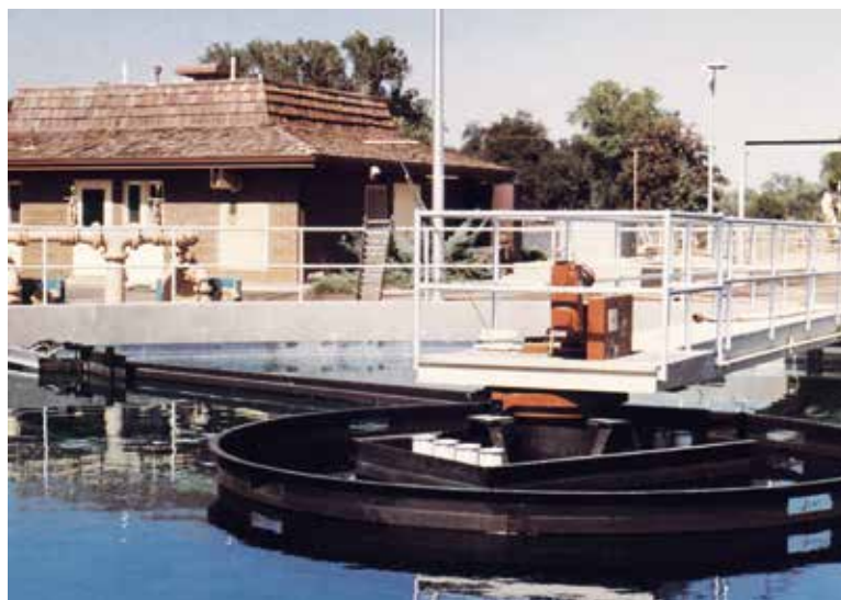
Obr. 2. Most dosazovací nádrže
